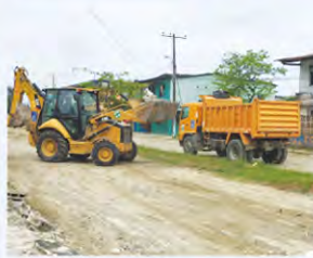
Maquinaria GAD Pacto en la zona afectada
